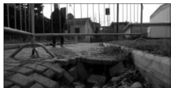
Un'immagine del degrado che affligge il giardino di via Frank
